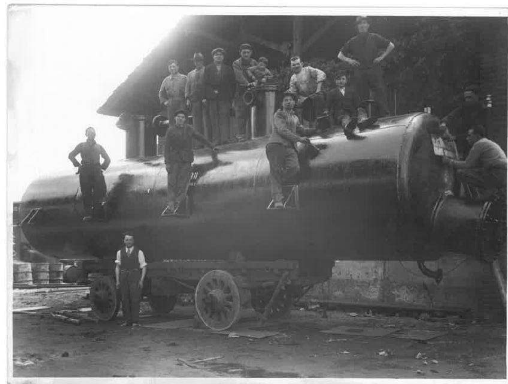
Generatore di vapore con fascio tubiero interno Materiale Carbon Steel Anni 50
