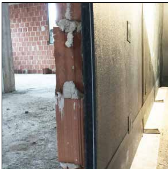
Keifom TA35N e fascia tagliamuro BFLEX FTM.
