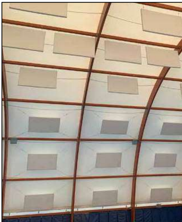
BFLEX NR applicato mediante appendini metallici a distanza regolare. Dimensione BFLEX NR 600X1200.
