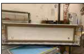
Esempio di cassonetto nuovo coibentato acusticamente e termicamente con BFLEX SC 4.2
