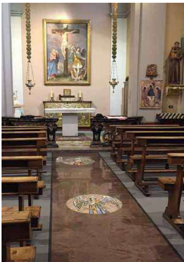
Es. visivo tappeto con impianto radiante elettrico terminato.
