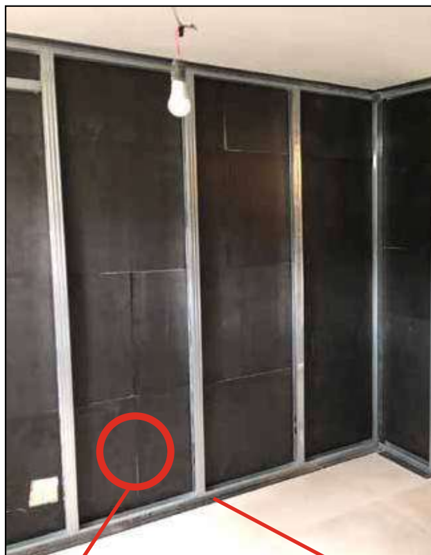
BFLEX BULL + BFLEX F9 - Sistema ad intercapedine in aderenza
