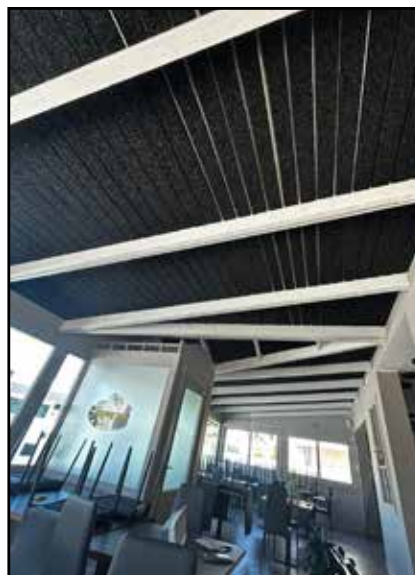
Soffitto realizzato con BFLEX NR spelato avvitato su struttura in acciaio
