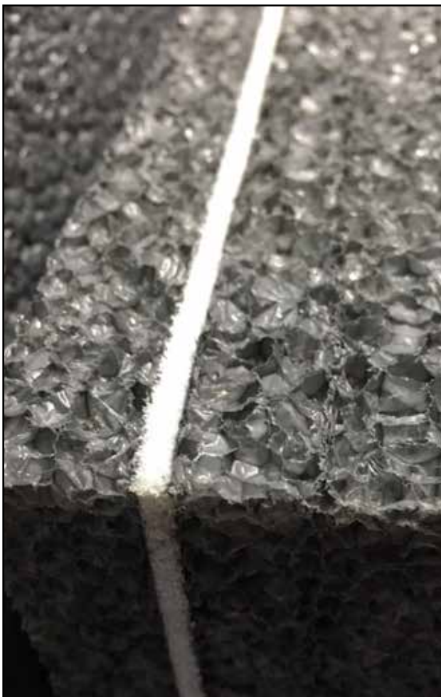
BFLEX NR con massa in PE all'interno.
