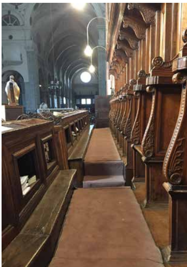
Es. visivo tappeto impianto radiante elettrico terminato.
