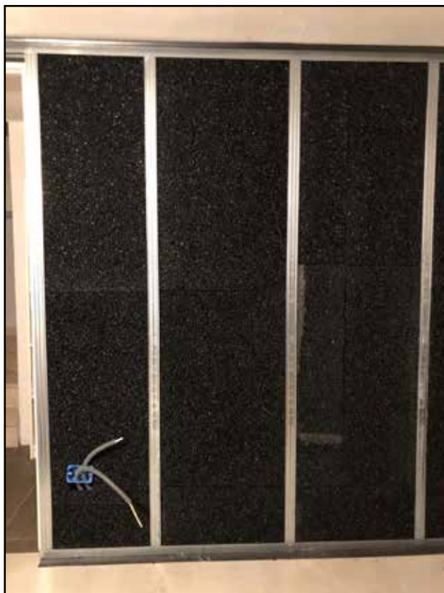
BFLEX BULL + BFLEX F9 - Sistema ad intercapedine in aderenza
