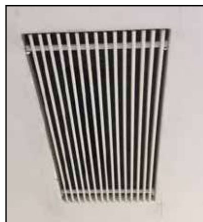
BFLEX NR spelato ambo i lati Esempi di realizzazione speciale per insonorizzare le bocchette di ripresa aria in un impianto di ventilazione meccanica.
