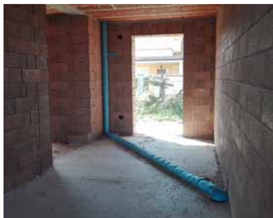
Il materiale isolante SONIK permette la non propagazione della vibrazione allo scarico al sottofondo.
