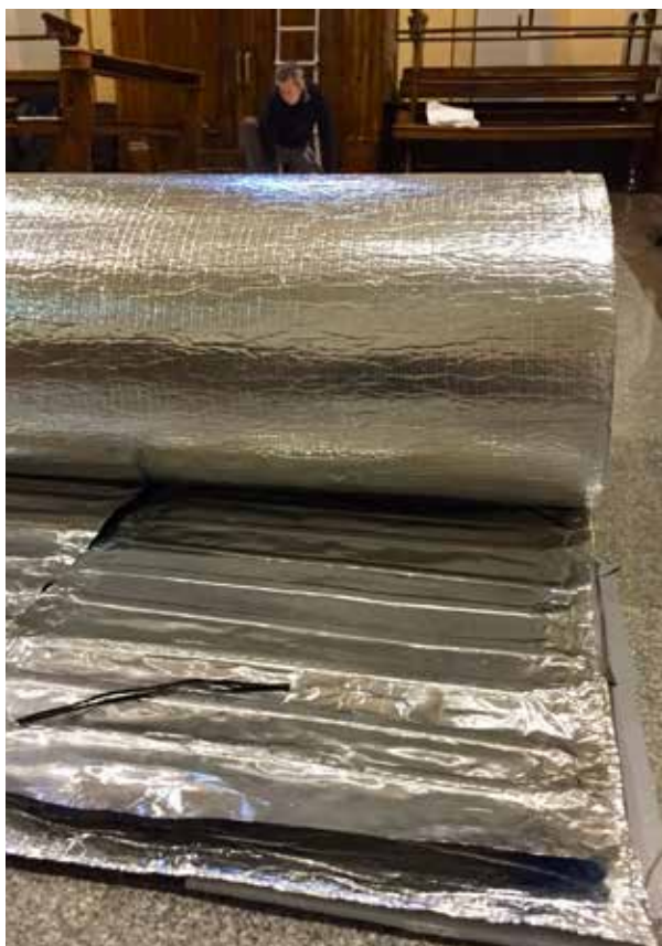
Fasi di posa BFLEX BRT/RF su impianto radiante elettrico
