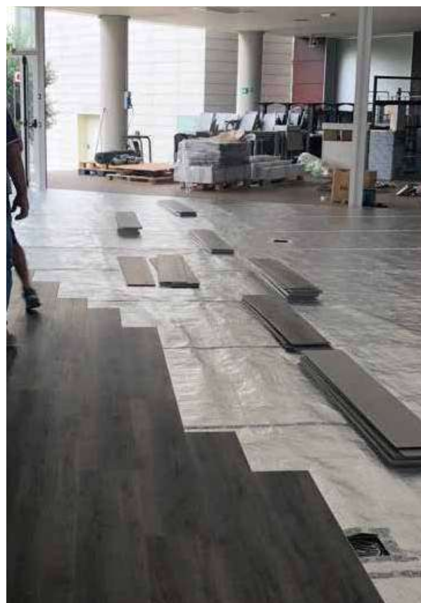
Es. visivo BFLEX BRT/RF applicato su pavimentazione flottante.
