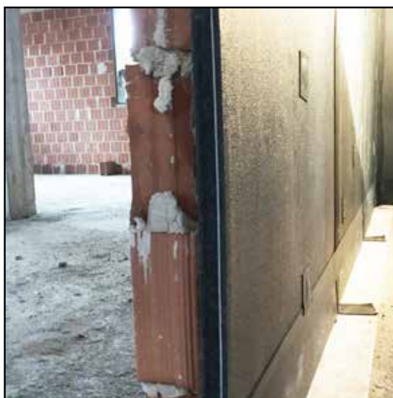
Keifom TA35N e fascia tagliamuro BFLEX FTM.
