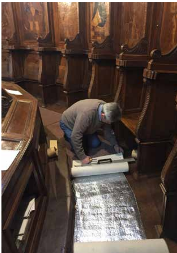
Fasi di posa BFLEX BRT/RF
