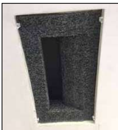
BFLEX NR spelato ambo i lati Esempi di realizzazione speciale per insonorizzare le bocchette di ripresa aria in un impianto di ventilazione meccanica.
