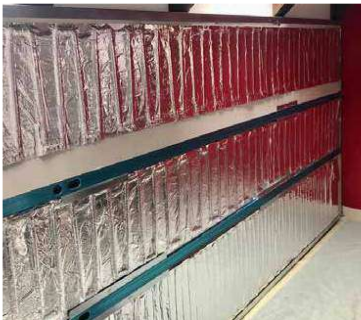
BFLEX BRT/RF abbinato ad impianto radiante elettrico ae posizionato a parete.
