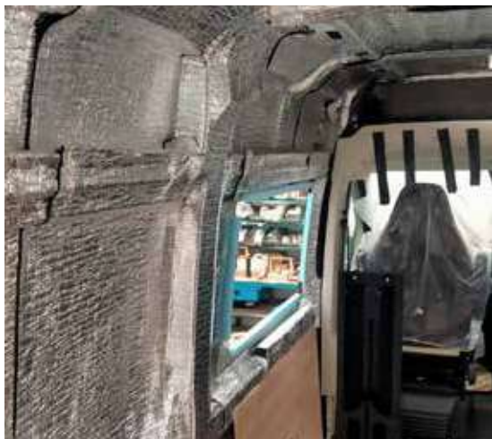
BFLEX BLU applicato su parete e soffitto interno caravan
