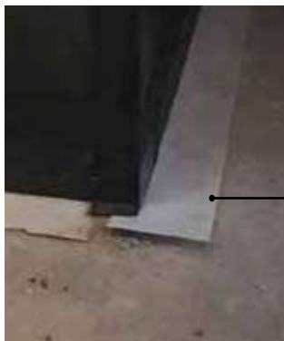
Fascia tagliamuro desolarizzante BFLEX FTM 3,3 D. 150 Kg/m 3 3,3 D. 250 Kg/m 3
