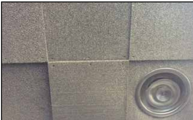
Soffitto acustico con impianto aria inserito direttamente su BFLEX NR
