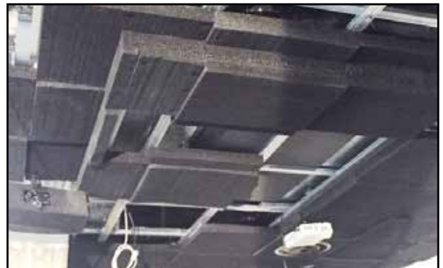
Soffitto realizzato con BFLEX NR spelato avvitato su struttura in acciaio
