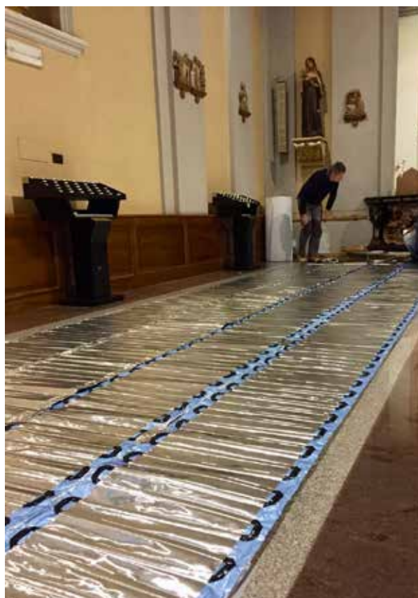
Es. visivo impianto radiante elettrico in preparazione.
