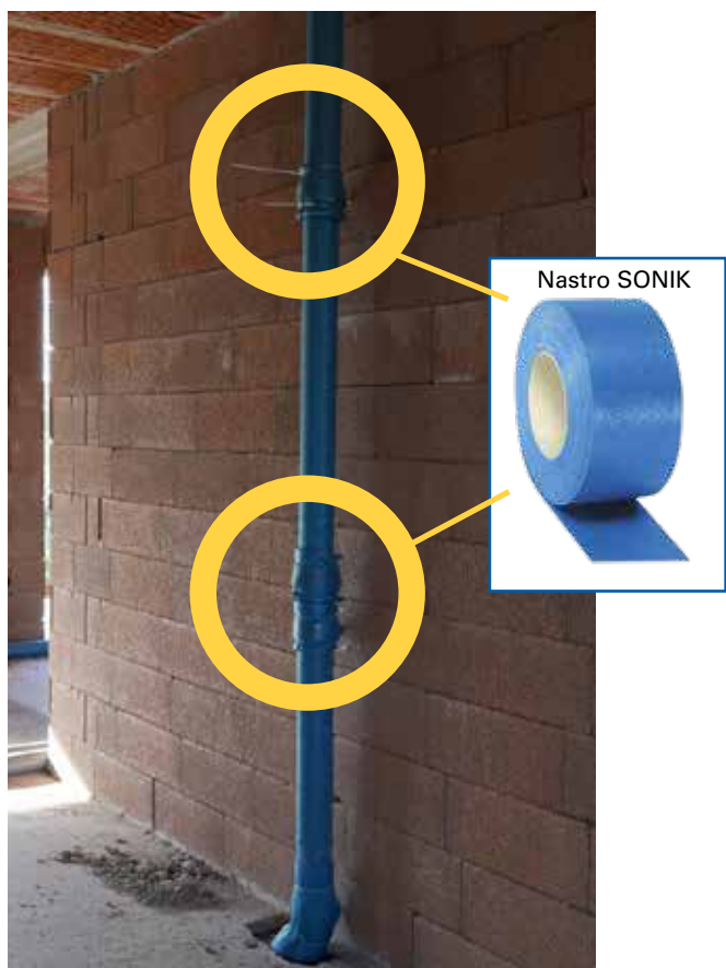
Unione tra i due isolanti acustici, fondamentale per il giusto isolamento, il nastro SONIK fissato con due fascette.
